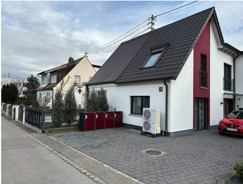
Sanierte Doppelhaushälfte - Beispiel
