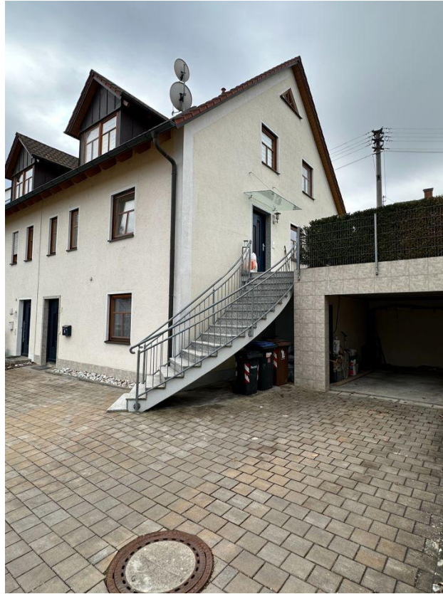
Zugang zum Hauseingang mit Garage und Stellplätze
