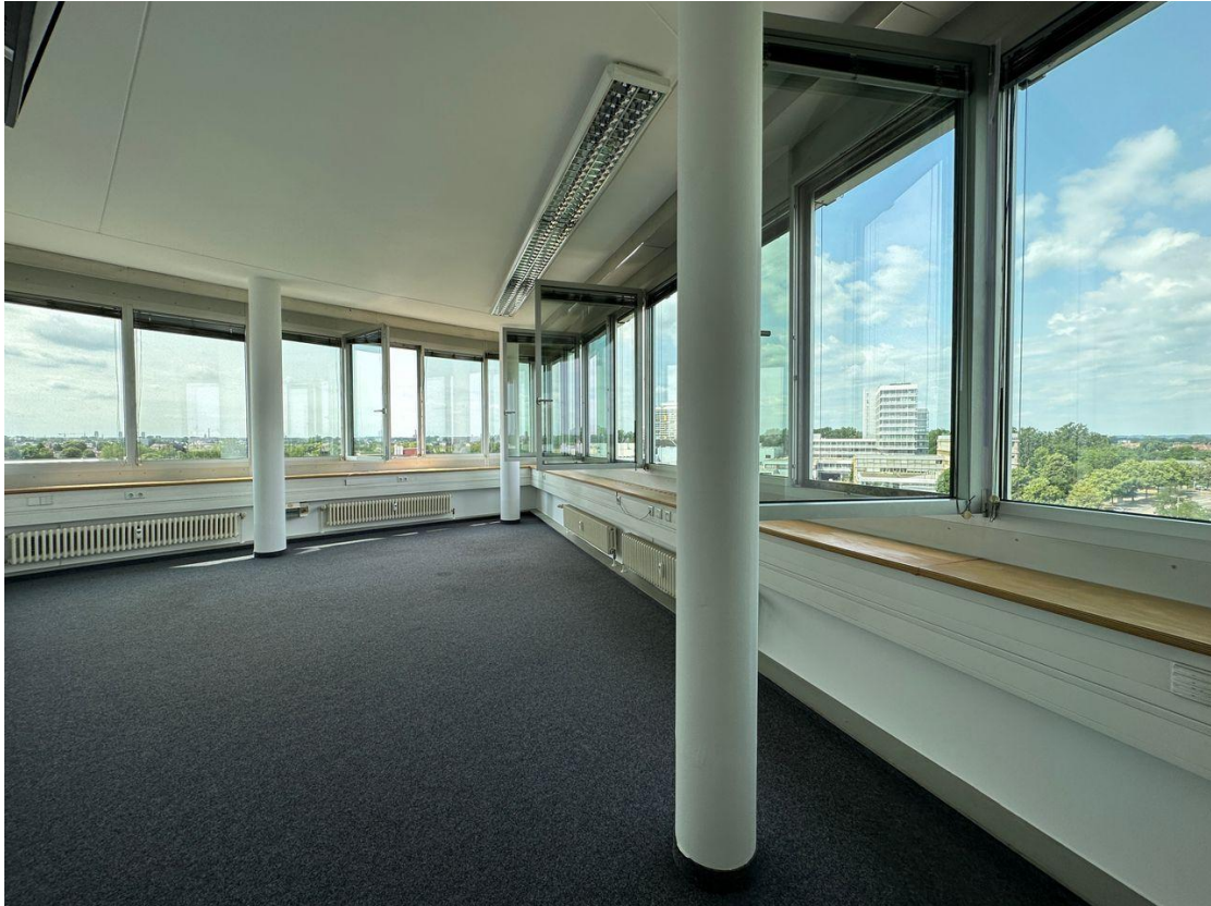
Raum 2 - Fenster mit elektrischen Rollläden
