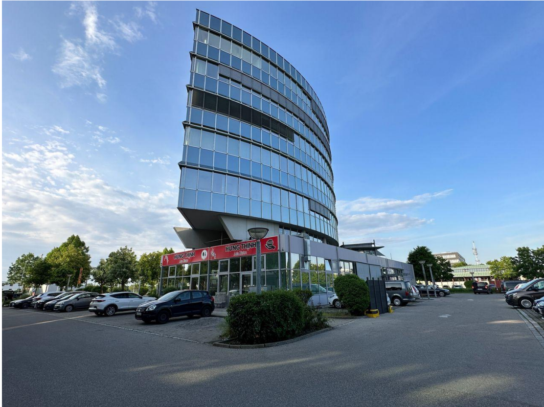
Seitliche Ansicht Gebäude
