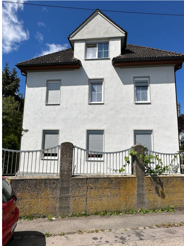
Außenansicht des Wohngebäudes
