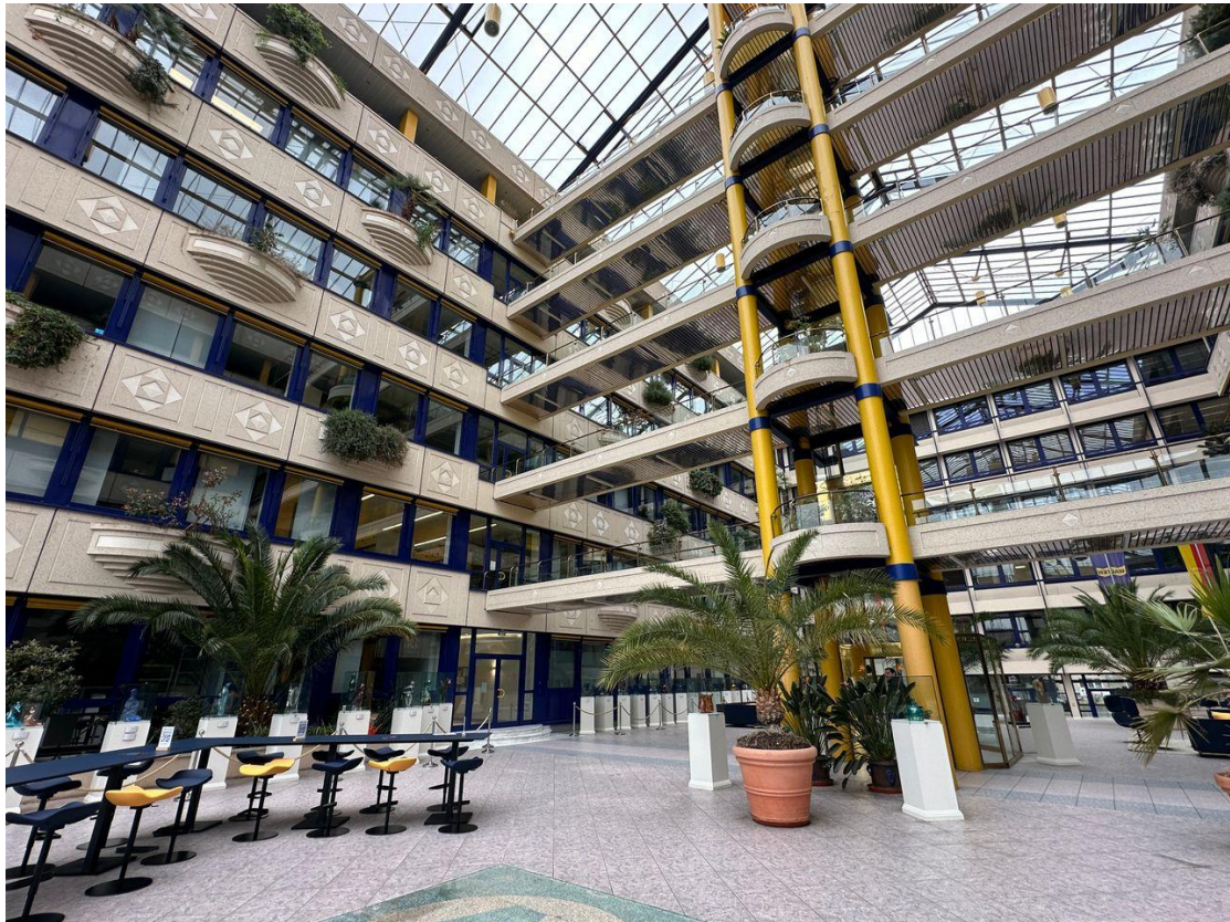
Innenbereich Atrium - Ansicht 4
