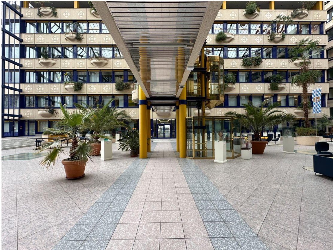
Innenbereich Atrium - Ansicht 1
