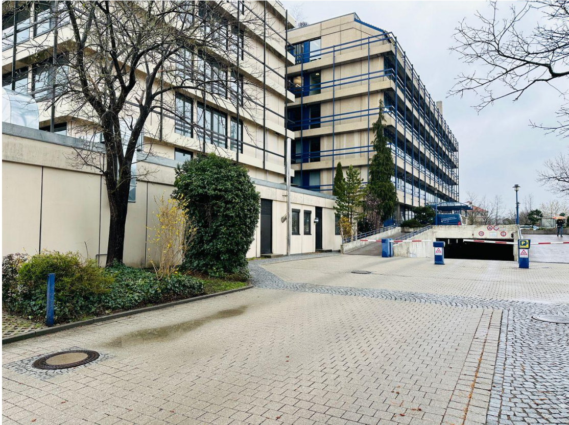
Außenansicht und TG-Zufahrt
