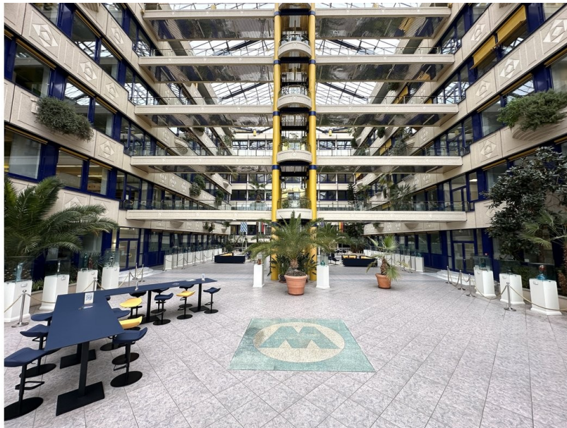
Innenbereich Atrium - Ansicht 5
