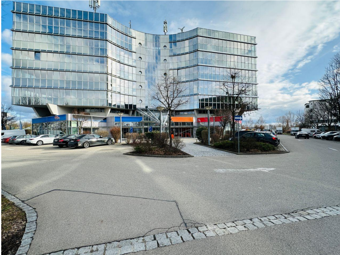
Vorderseite des Gebäudes und Parkplätze
