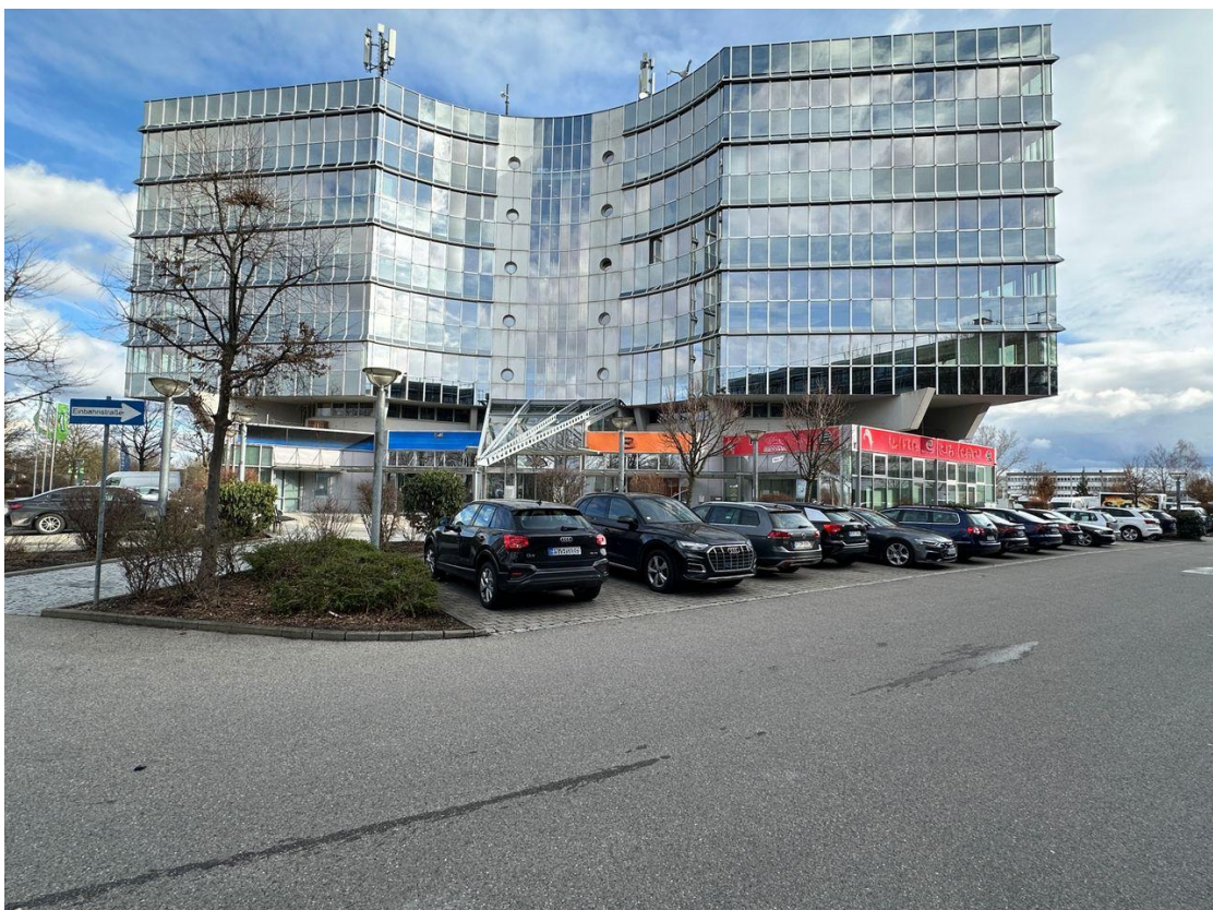
Vorderseite des Gebäudes und Parkplätze
