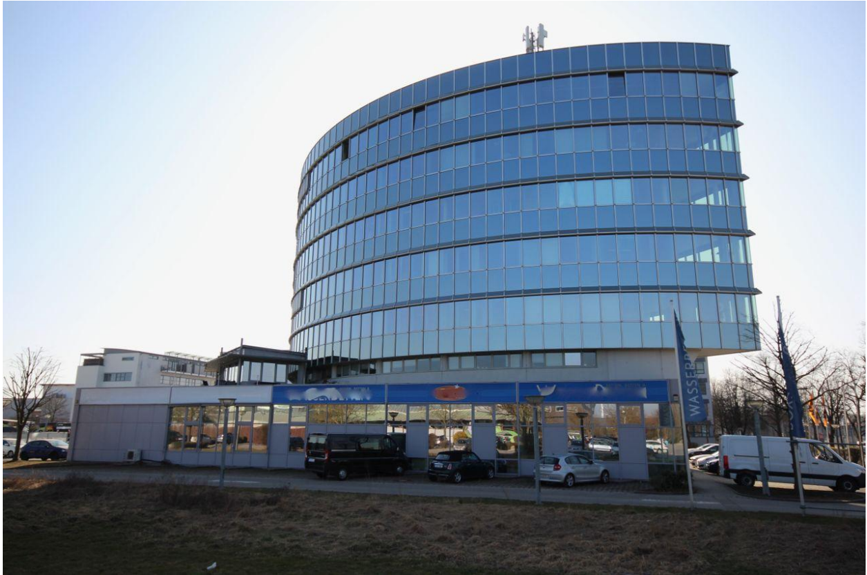
Blick auf das Gebäude von Osten
