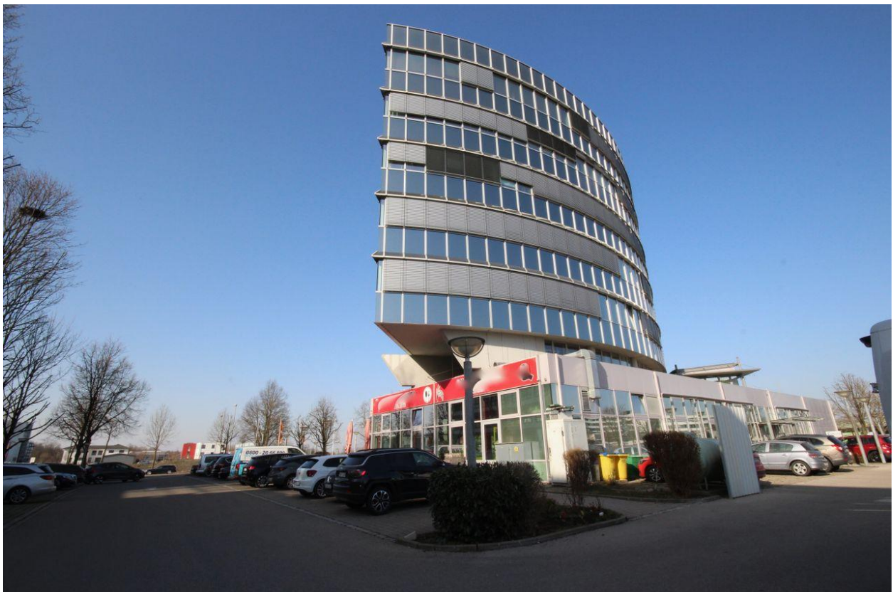
Blick auf das Gebäude von Westen mit Parkplätzen
