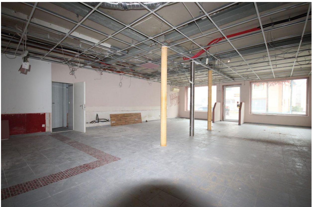
Raum 1 - wird noch fertig verputzt
