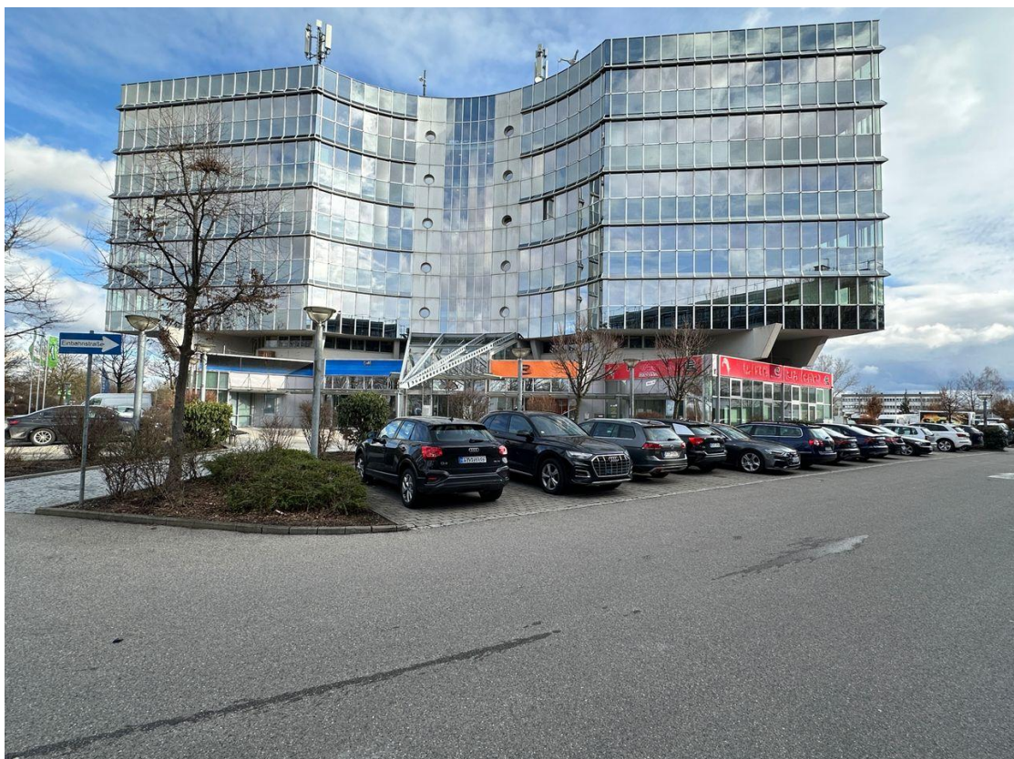
Vorderseite des Gebäudes und Parkplätze
