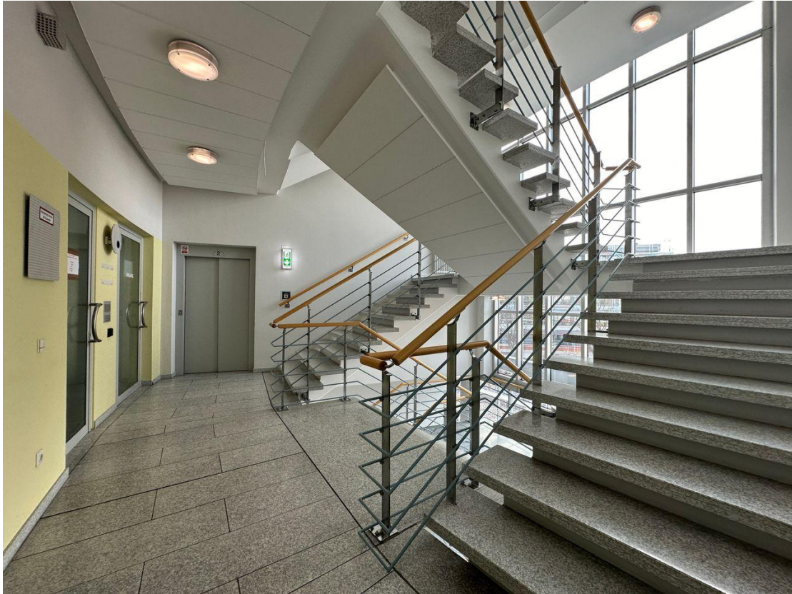
Treppenhaus und Aufzüge
