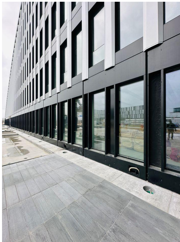
Außenansicht des Innovationsbogens
