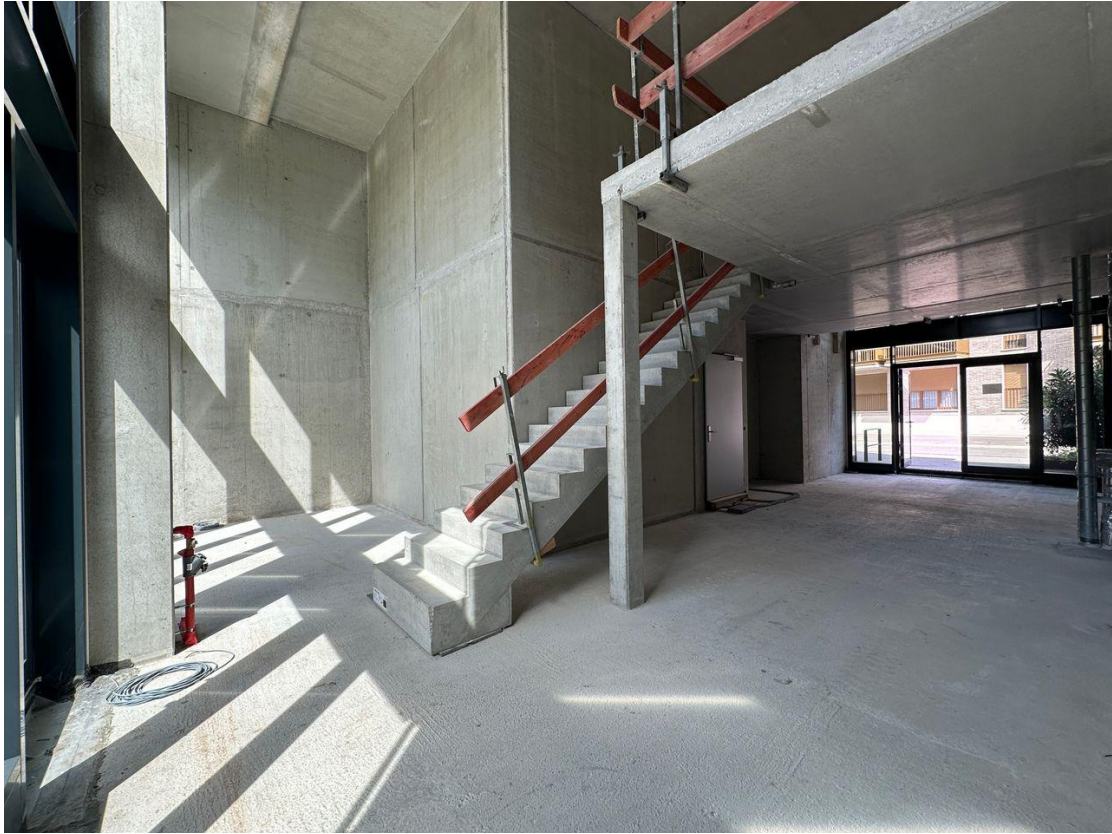
Aufgang zum Obergeschoss
