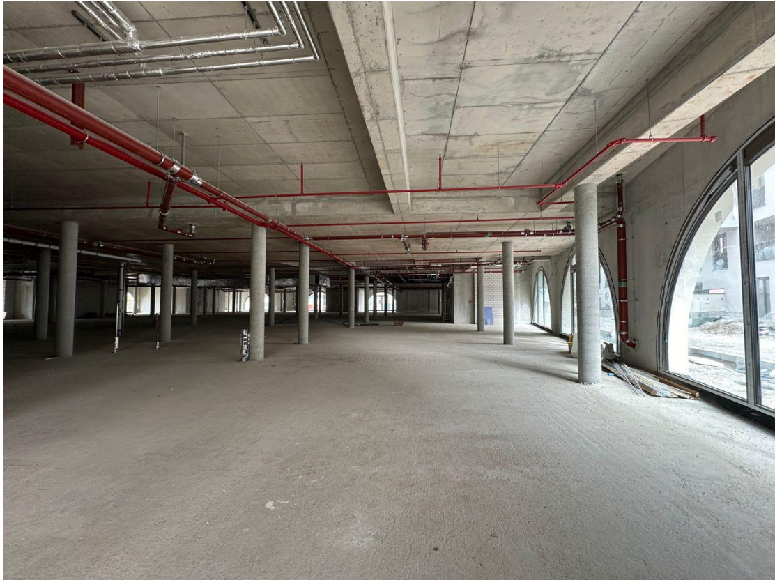
Innenansicht im Rohbau
