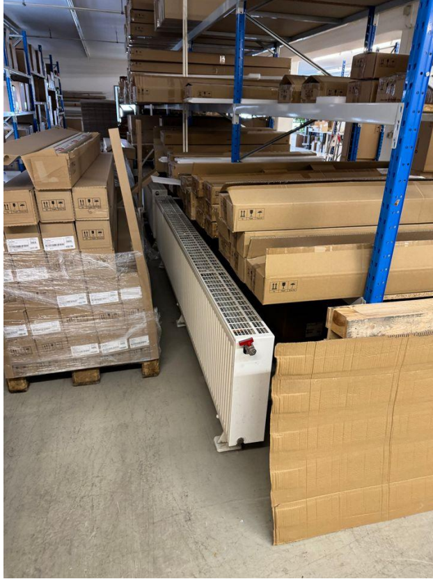
Heizung in der Lagerfläche
