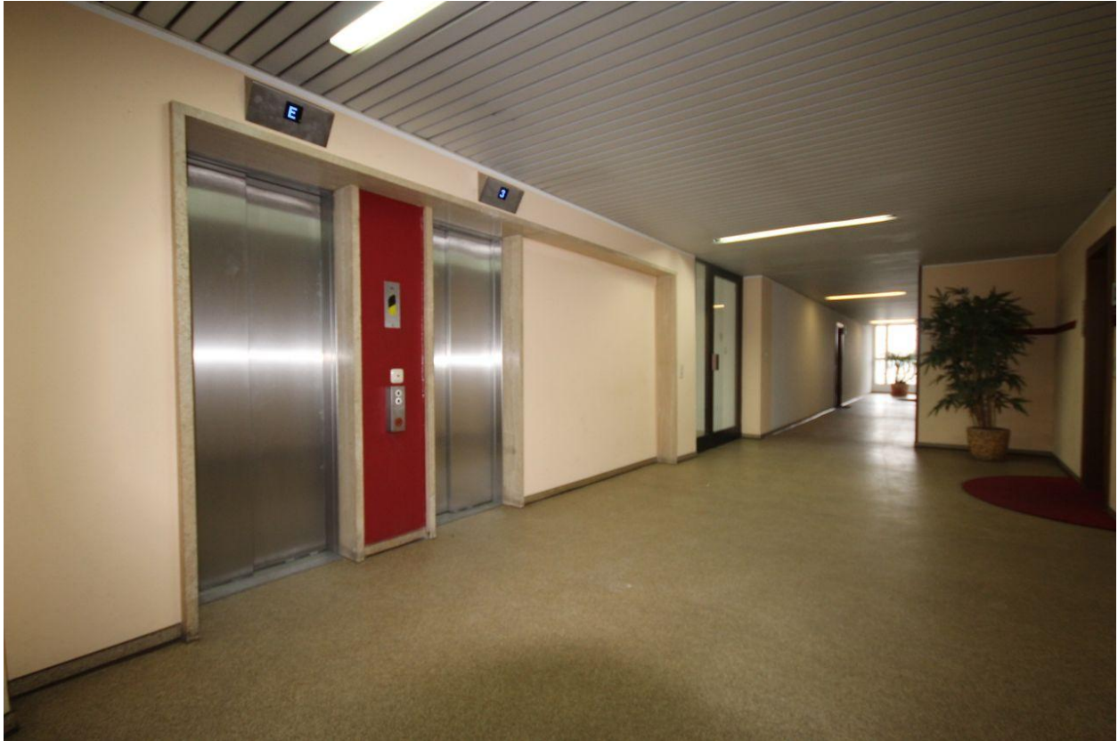
mit Aufzug (barrierefrei)
