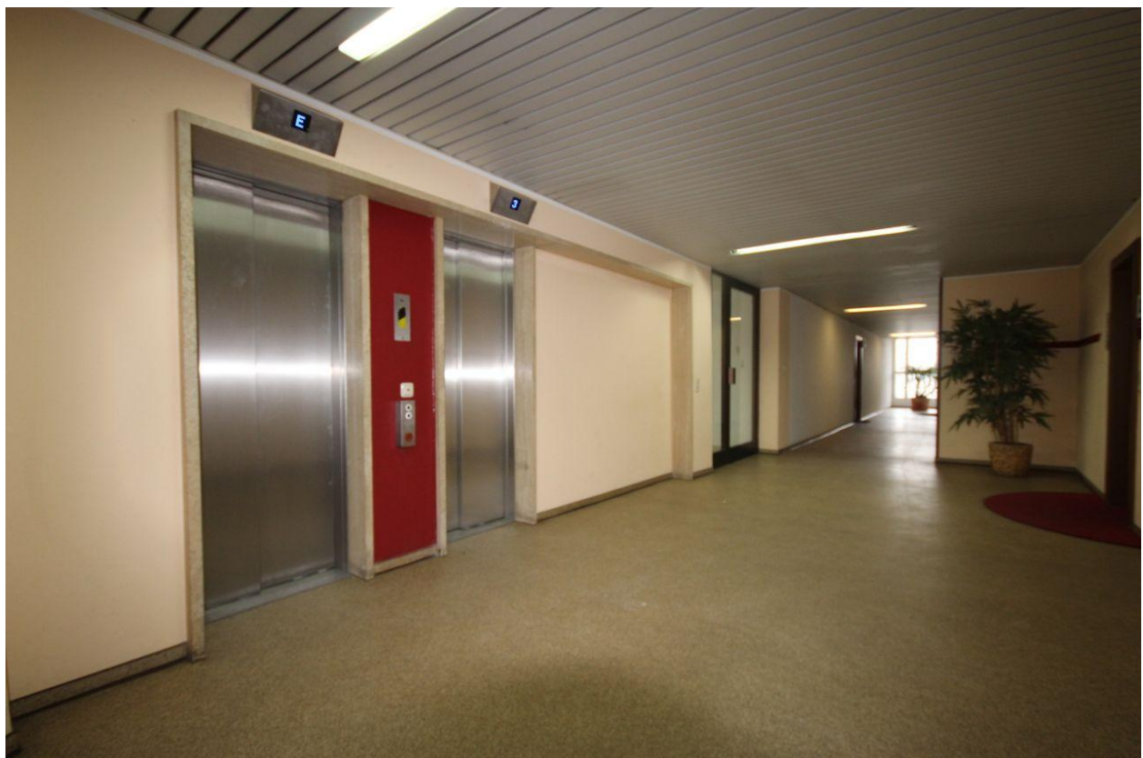
mit Aufzug (barrierefrei)
