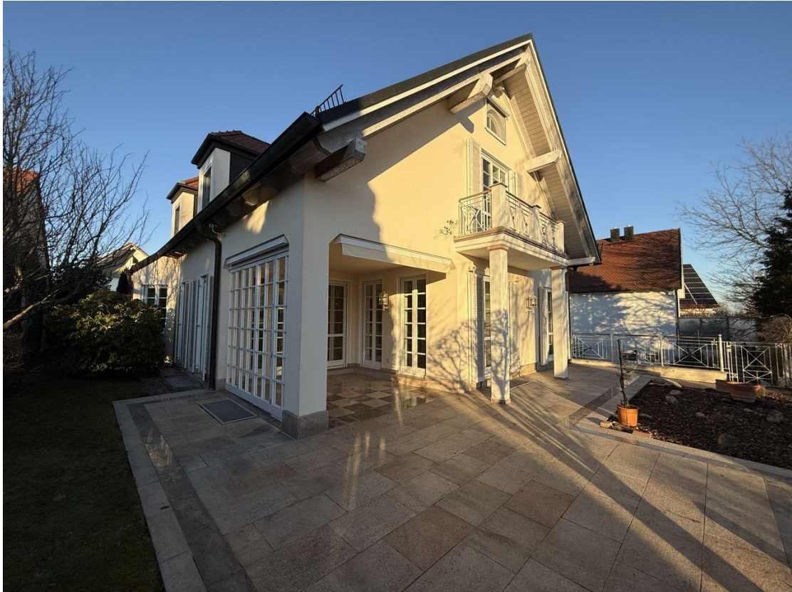
Terrasse und Wintergarten
