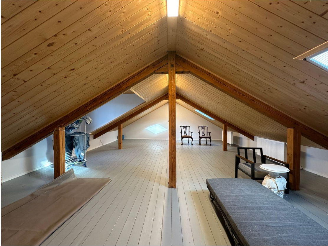
Büroraum 2 im DG
