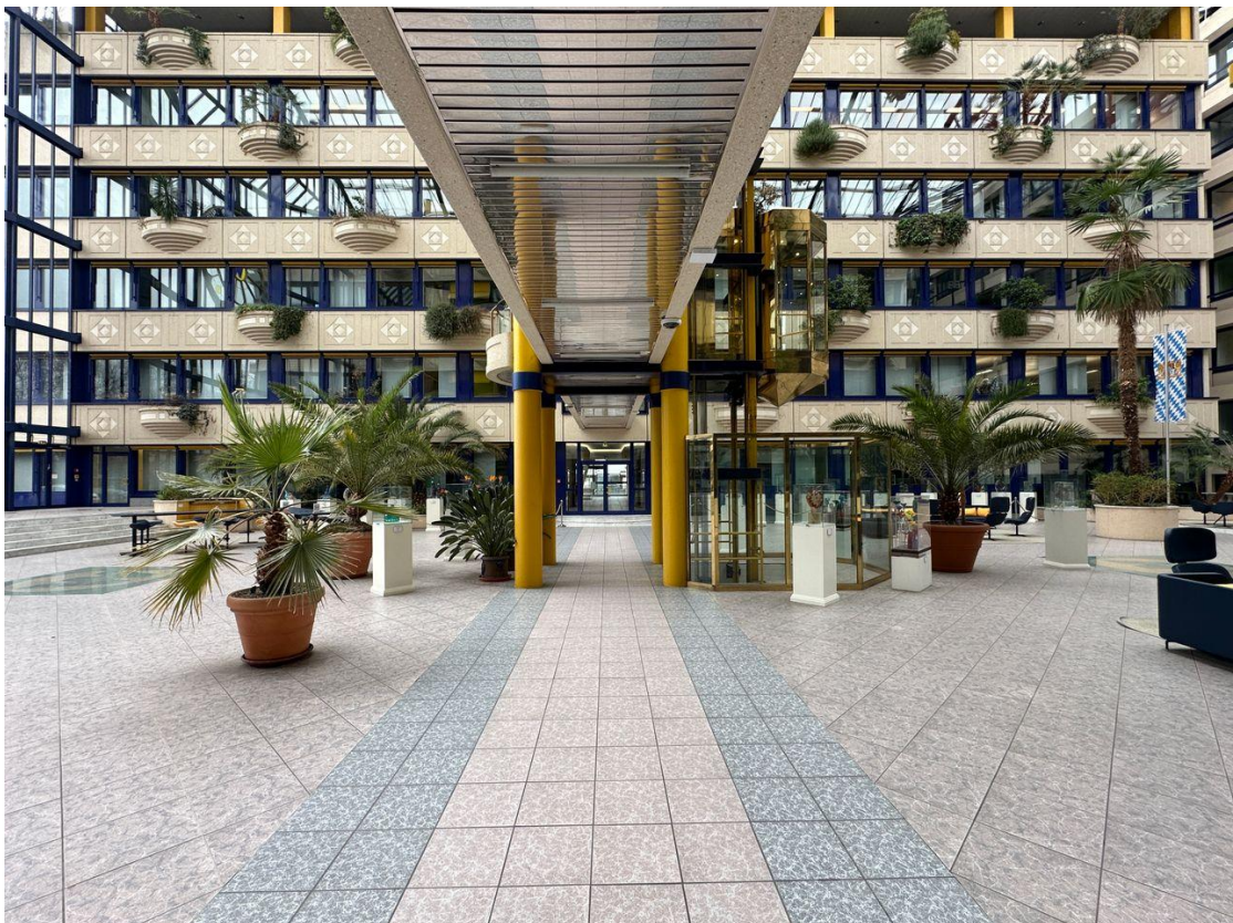
Innenbereich Atrium - Ansicht 1
