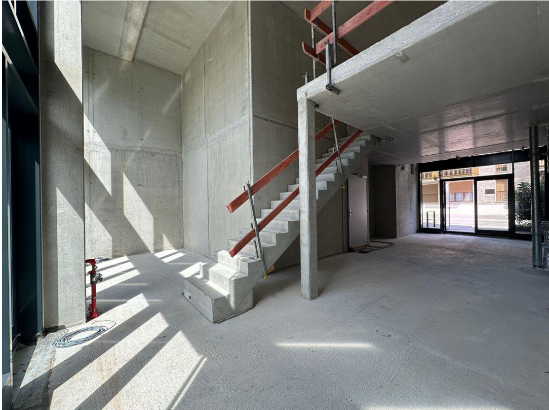
Aufgang zum Obergeschoss
