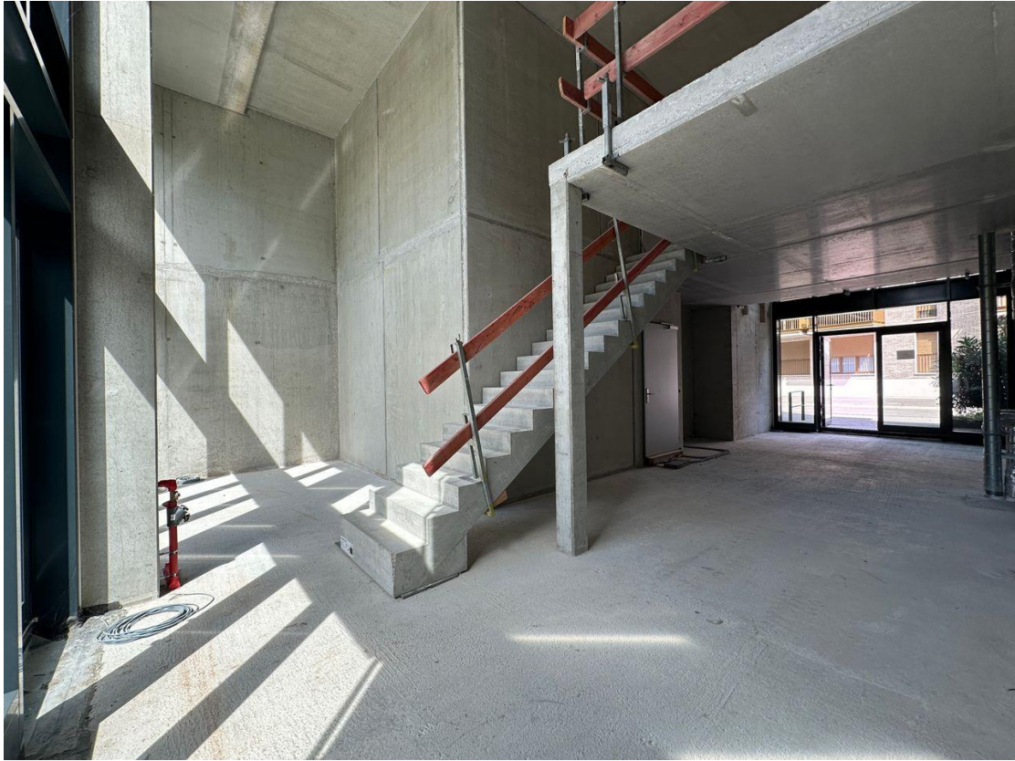
Aufgang zum Obergeschoss
